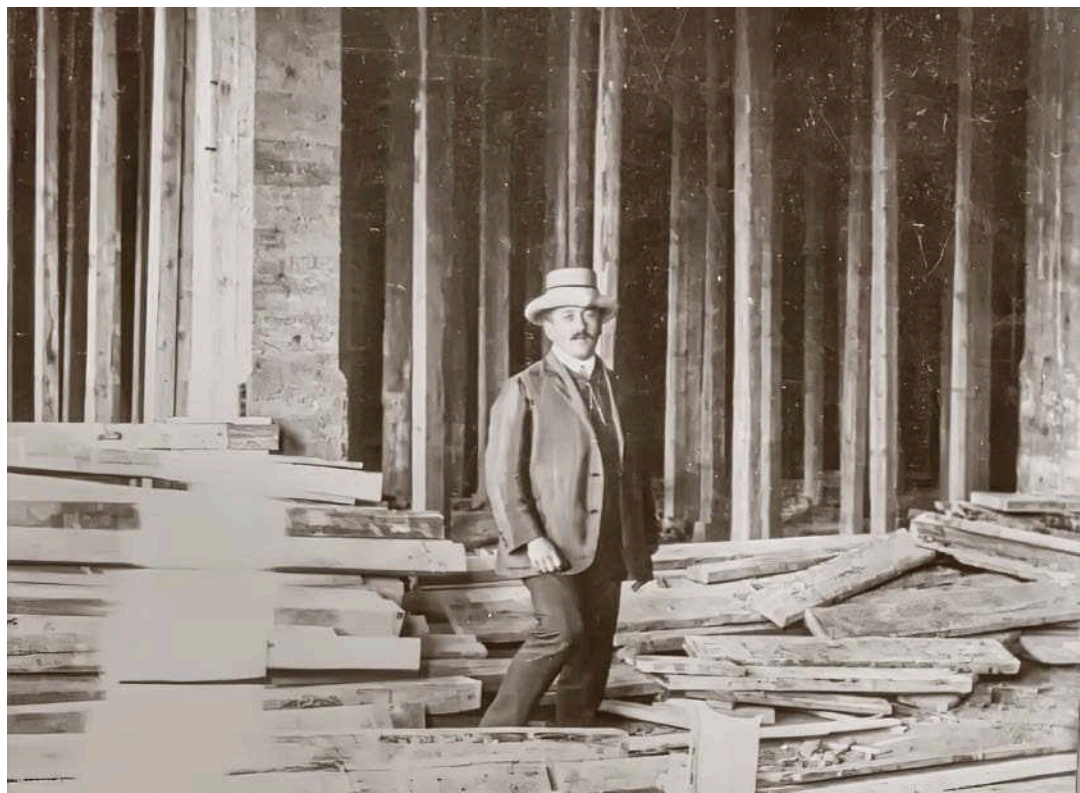
Prohlídka spáleniště a vyklízení továrny pod dohledem MUDr. Josefa Hyblera. (SOka Semily, SbF)
