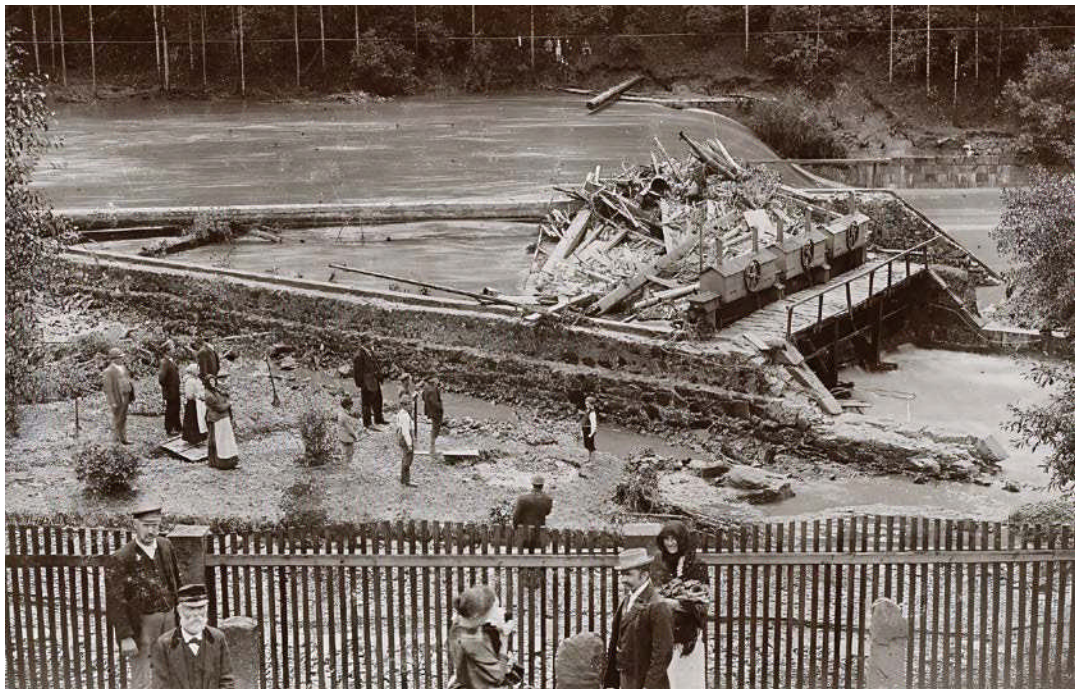
Povodeň roku 1897 způsobila velké škody také na stavidle tiskárny látek firmy F. Schmitt v Semilech. Foto Ludvík Kwaysser. (SOkA Semily, SbF)
