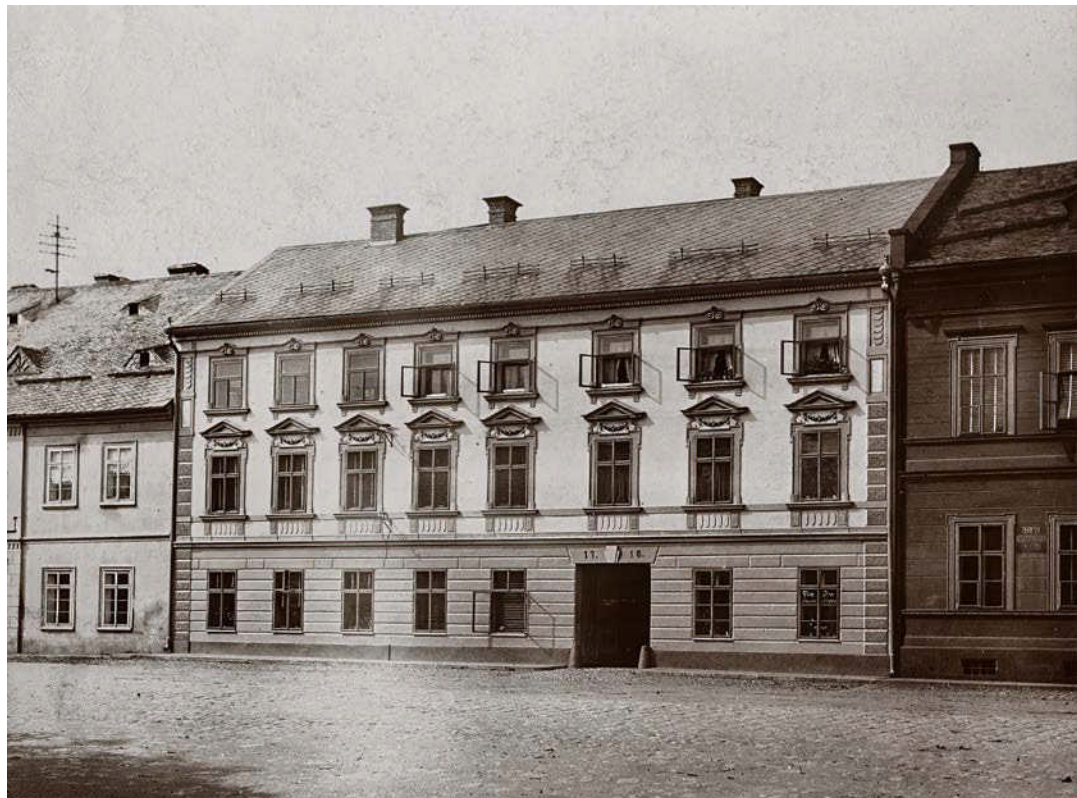
Sídlo firmy v Semilech čp. 16/17 po přístavbě druhého patra a scelení fasády. Z bývalého kupeckého krámu zůstal jen prodej piva v lahvích, vína a likérů. (SOkA Semily, SbF)
