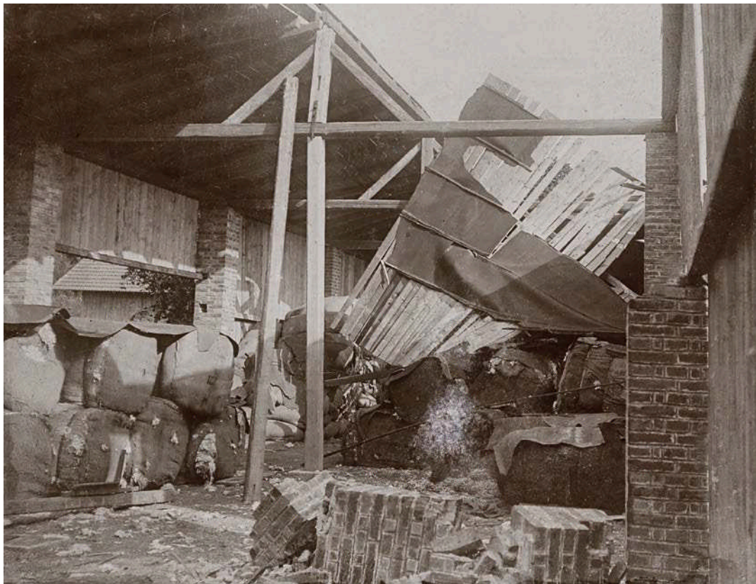
Orkánem zdemolovaná budova továrny. (RA Hyblerových)
